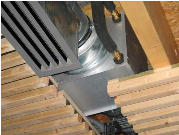
Batterie de chauffage terminale
