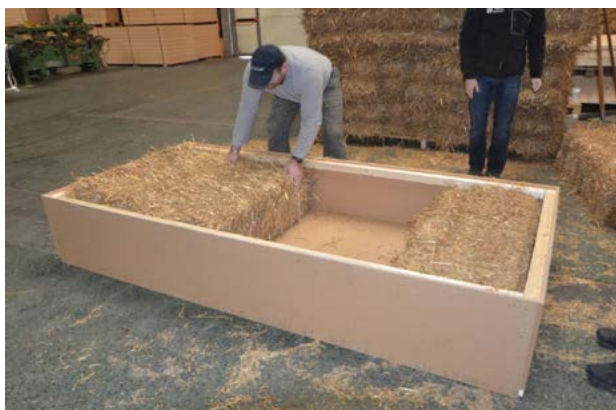
Mise en place des caissons de paille
