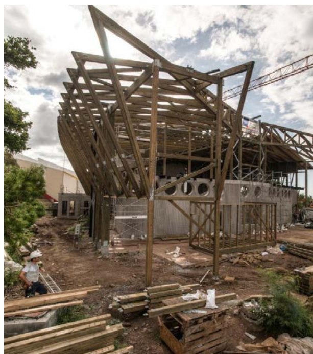
Mise en place de la charpente
