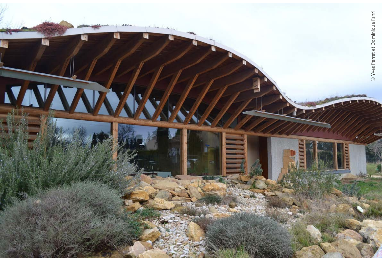
Façade Sud du Naturoptère
