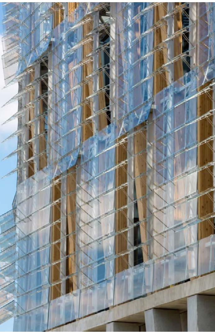
Façade et cour du Conseil Général
