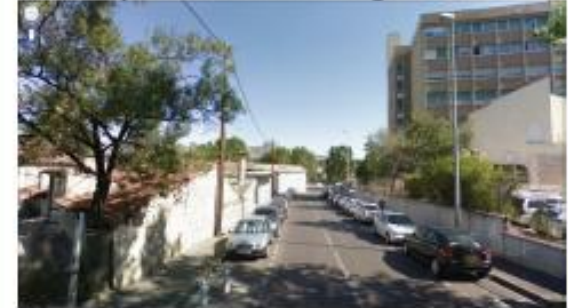
Est – Hôpital – environ 9 étages
