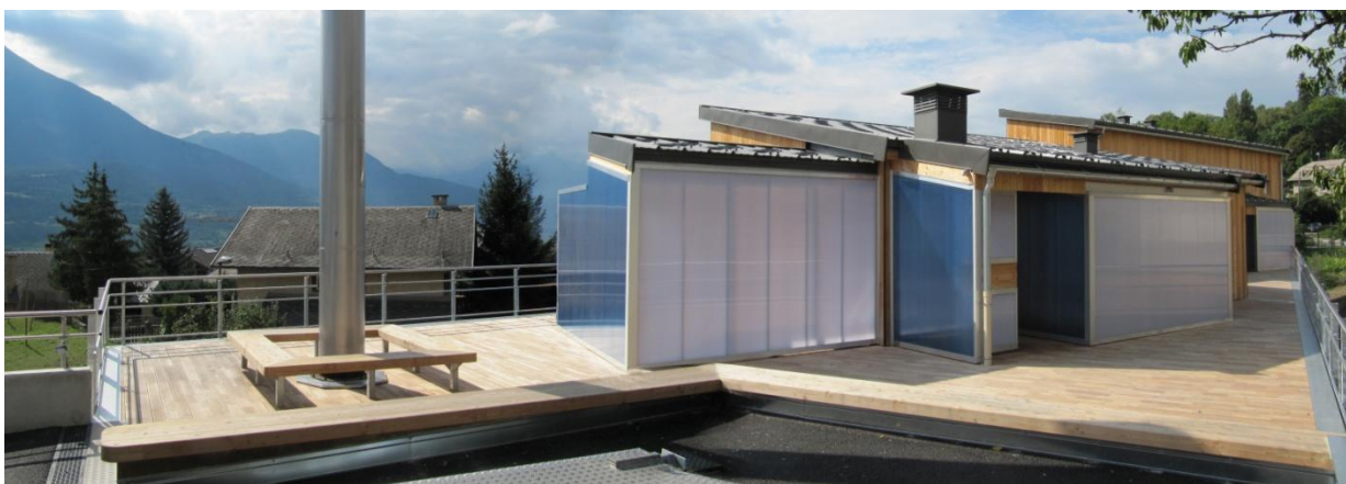
Façade Nord Est
