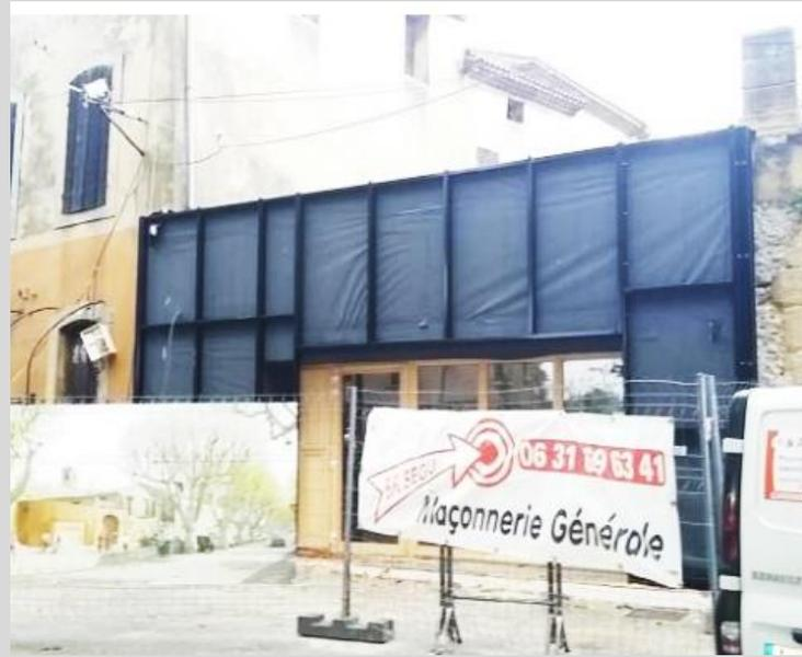
Ossature métallique support de bardage mise en place
