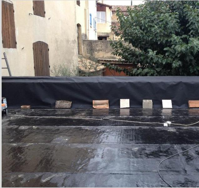
Etanchéité provisoire de la toiture terrasse + protections des ouvrages en fibre de bois
