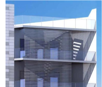
Brise soleil Façades Est et Ouest
