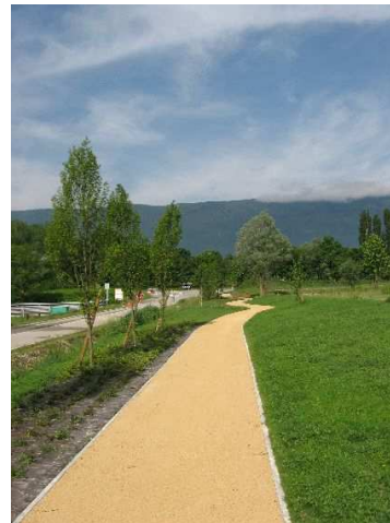
Aménagement chemin piéton (printemps 2008)
