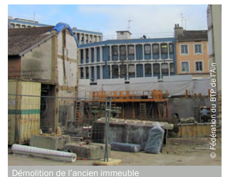
Démolition de l'ancien immeuble
