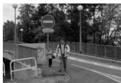
Photo 19 - Passerelle mixte vélos-piétons
