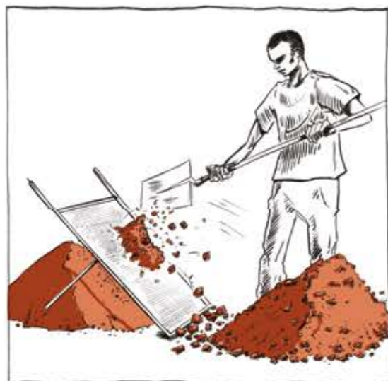
LORS DE SA PRÉPARATION, LA TERRE EST BROYÉE ET TAMISÉE POUR OBTENIR UN MATÉRIAU PULVÉRULENT, HUMIDE ET HOMOGENE.
