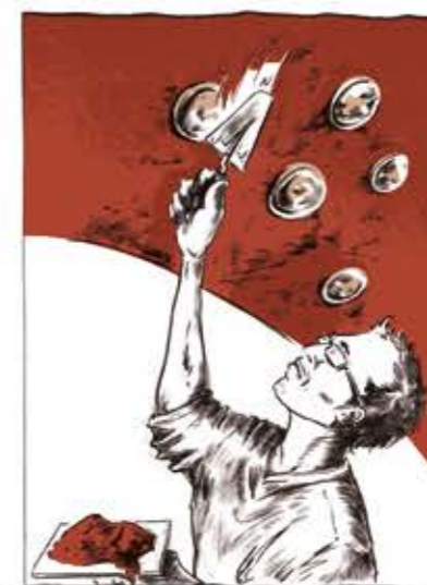
LE CORPS DE L'ENDUIT SERT À BOUCHER LES TROUS ET À HOMOGENÉISER LA SURFACE. CE MÉLANGE TRÈS SABLEUX ET/OU FIBREUX DE 2 À 3 CM D'ÉPAISSEUR EST APPLIQUÉ AVEC UNE TALOCHE OU UNE TRUELLE.
