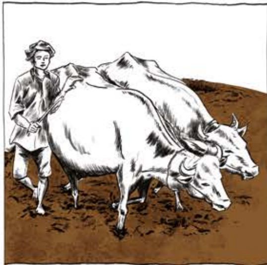
LA TERRE, SOUVENT EXTRAITE DU SITE, EST MALAXÉE À L'ÉTAT PLASTIQUE (15 À 30% D'EAU). ICI, ELLE A ÉTÉ ADDITIONNÉE DE PAILLE DE RIZ ET MALAXÉE PAR DES BUFFLES.
