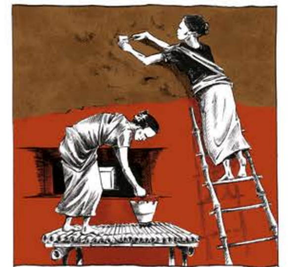
LE MUR EST DÉBARRASSÉ DES BOUTS DE PAILLES QUI DÉPASSENT AFIN DE PRÉPARER UNE PAROI PLANE. SI LA SURFACE DOIT ÊTRE ENSUITE, ELLE EST PRÉPARÉE PAR SCARIFICATION OU GRATAGE POUR PERMETTRE UN BON ACCROCHAGE.
