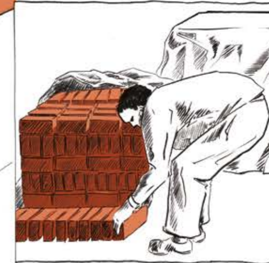
QUAND ILS SONT STABILISÉS, LES BLOCS SONT EMPILÉS DANS UNE ZONE DE STOCKAGE POUR EFFECTUER UNE CURE HUMIDE SOUS BÂCHE D'ENVIRON 28 JOURS.
