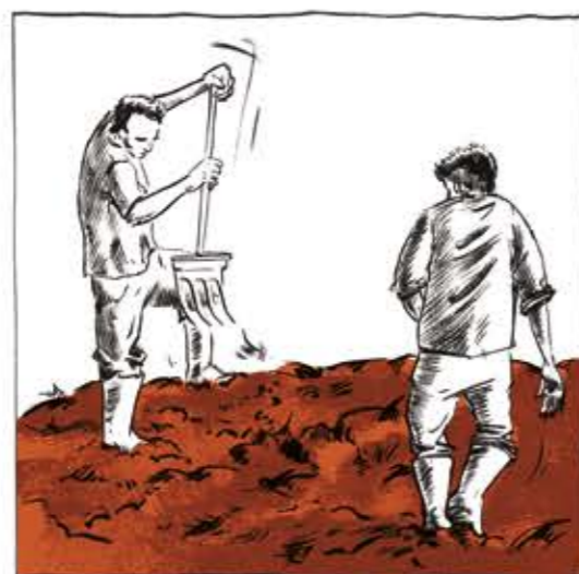
LA TERRE EST MALAXÉE AVEC DE L'EAU (15 À 30 %) POUR OBTENIR UN MÉLANGE HOMOGÈNE À L'ÉTAT PLASTIQUE, AMENDÉ ICI AVEC DE LA PAILLE.
