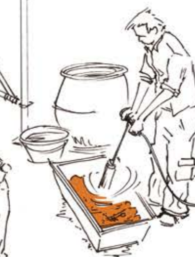
LA DERNIÈRE COUCHE EST TRÈS FINE. ICI, LE MÉLANGE D'ARGILE, SABLE FIN ET CIRE A ÉTÉ APPLIQUÉ À LA TRUELLE ET POLI POUR OBTENIR UNE FINITION BRILLANTE.
