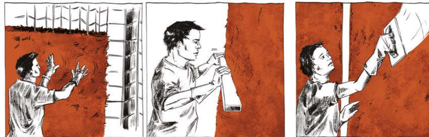
LA TERRE EST LISSÉE À LA MAIN.
