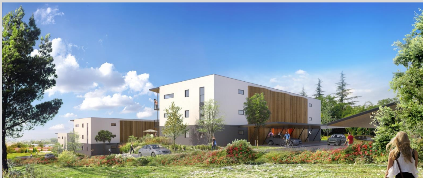
Façades Nord est & Nord ouest
