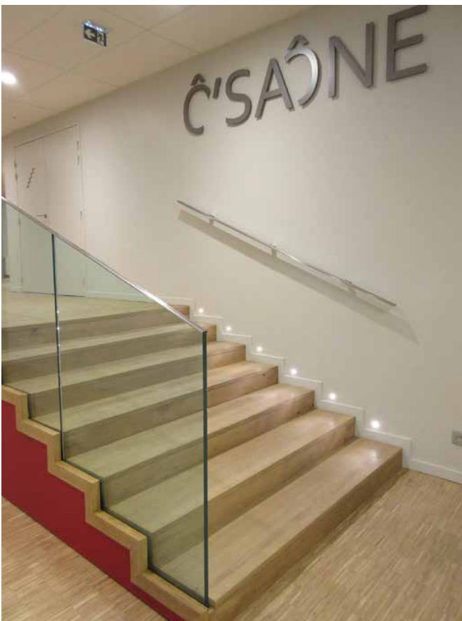
Choix de matériaux « nobles » : le parquet sur champs situé dans le hall est en chêne, les éléments de façade sont en pin (avec lasure Walsit), matériau compatible avec le zinc
