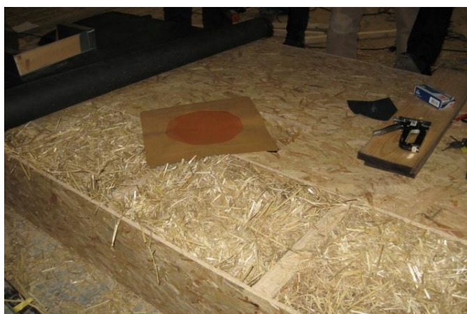
Mur en paille préfabriqué et pose sur chantier Source : http://www.lemoniteur.fr « Bâtiment industriel bois paille avec mur coupe-feu deux heures »
