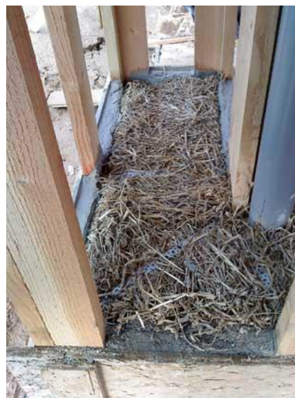
Isolation par la technique du GREB Source : http://terremere.fr/Greb.html
