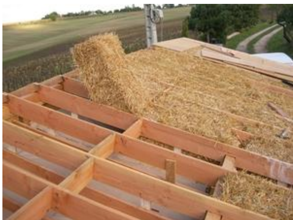
Isolation d'une toiture Source : http://www.habitat-ecologique.org
