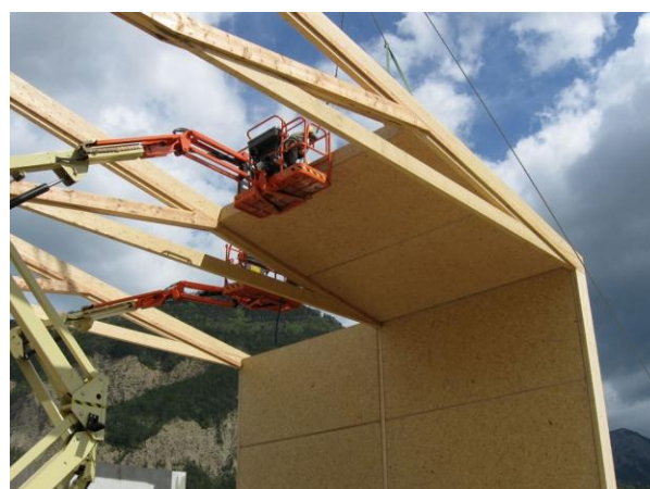
Mur en paille préfabriqué et pose sur chantier Source : http://www.lemoniteur.fr « Bâtiment industriel bois paille avec mur coupe-feu deux heures »
