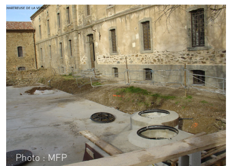
Regards d'accès du bassin de stockage dans la cour d'honneur
