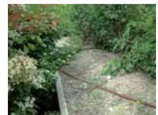
Exemple de goutte à goutte (Digne les Bains, 04)
