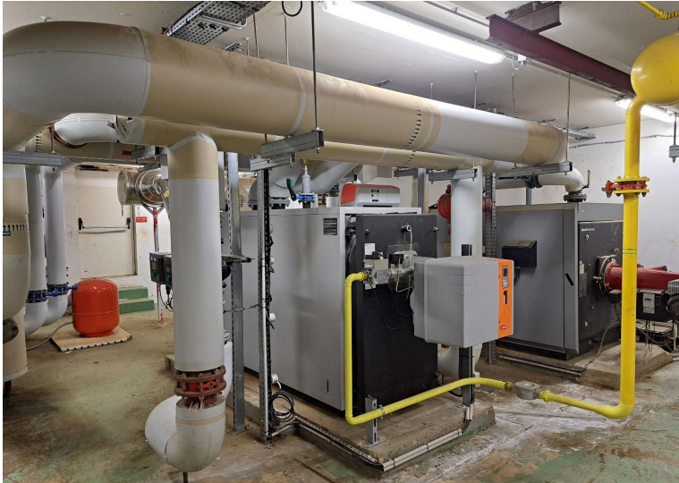
➤ Nouvelle chaudière gaz à condensation de 840 kW
