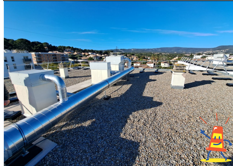
➤ Ventilation mécanique basse pression Hygro A
