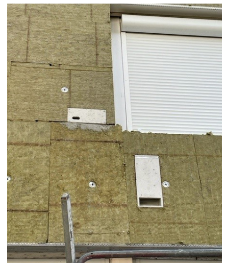
Réserve dans l'isolant avec coupure isolante pour intégration gîte à chiroptères site pilote d'Orly © Elsa Caudron
