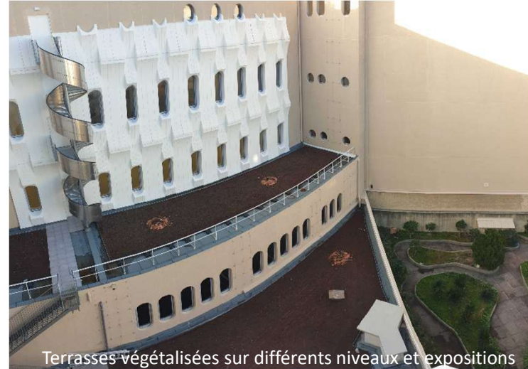
Une des 2 seules toitures terrasses accessibles aux occupants
