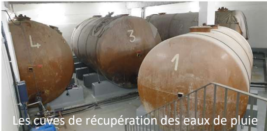
Relevage des eaux de pluie
