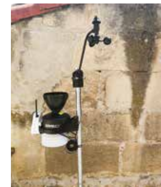
Station météo située sur le toit de la mairie d'Arles
