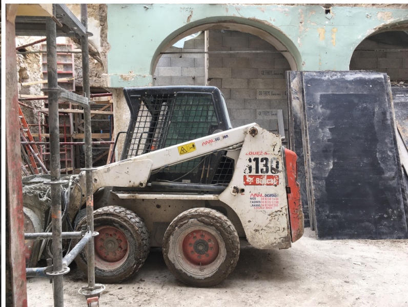
L'Abeille Nice — Immeuble en bois 2019 — Nice le port — France RÉNOVATION - SURÉLÉVATION
