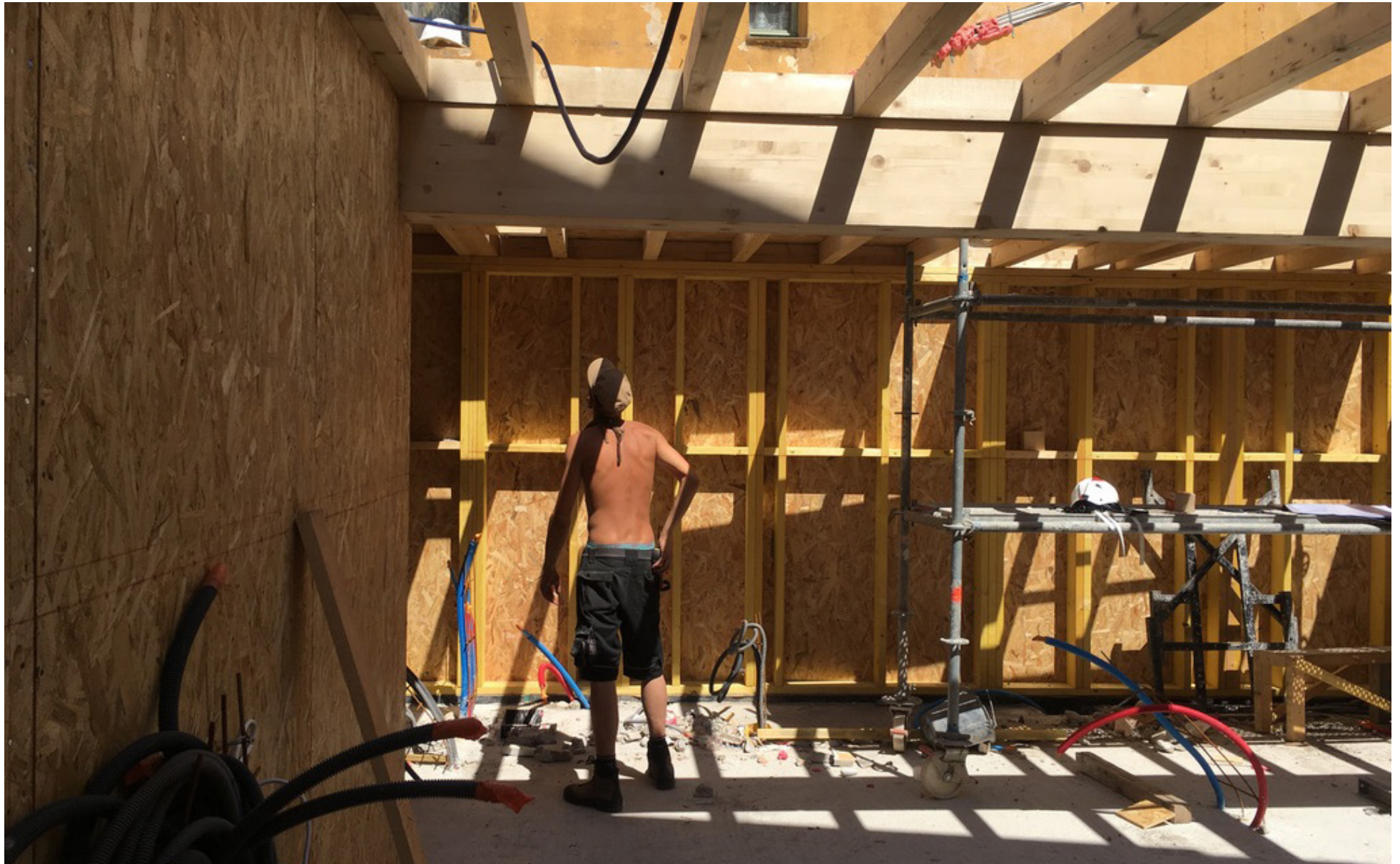
L'Abeille Nice — Immeuble en bois 2019 — Nice le port — France RÉNOVATION - SURÉLÉVATION
