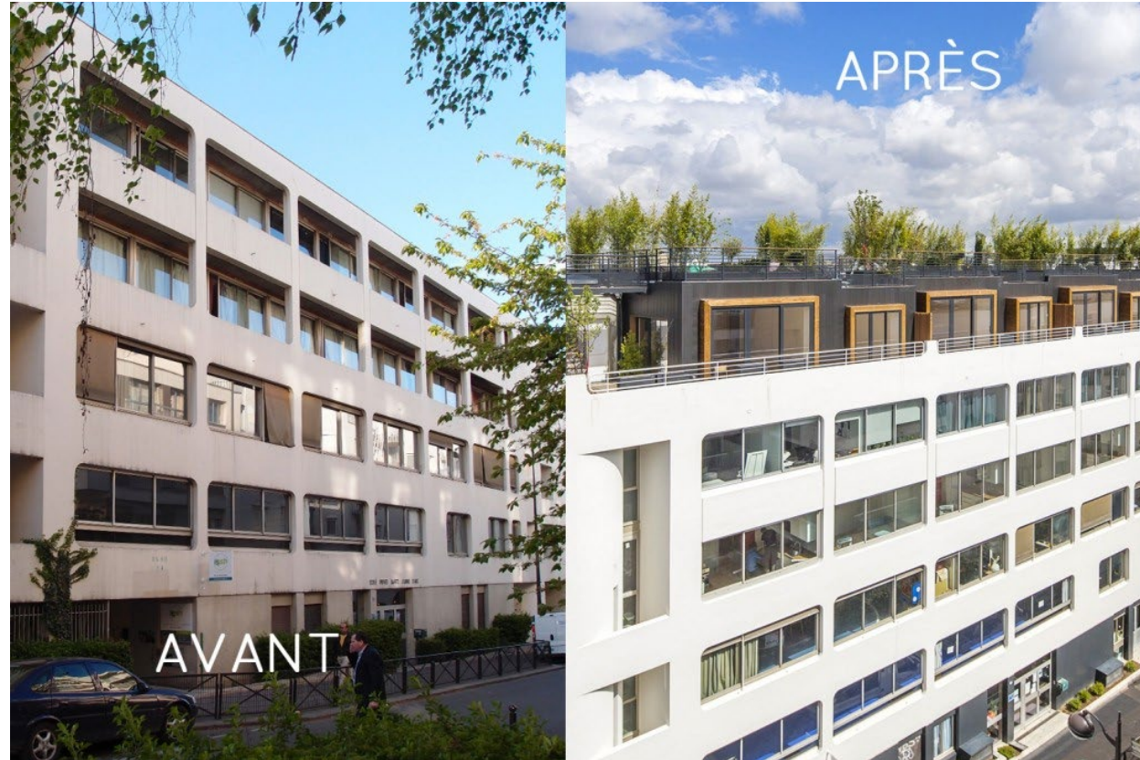
Surélévation de 1 niveau - SDP 500 m 2 - Architecte Vincent Eschalier 24 Rue Charcot à PARIS 13ème
