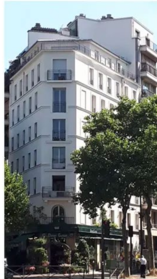
Immeuble après travaux
