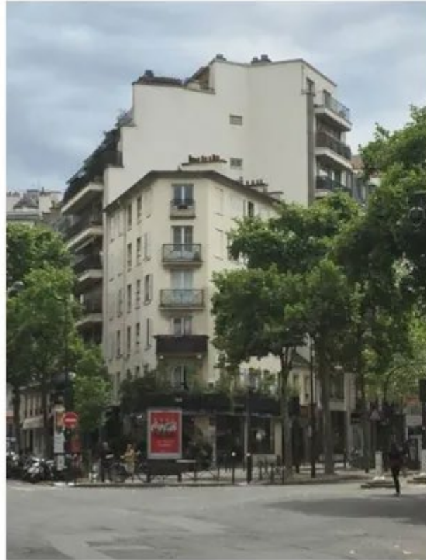
Immeuble avant travaux
