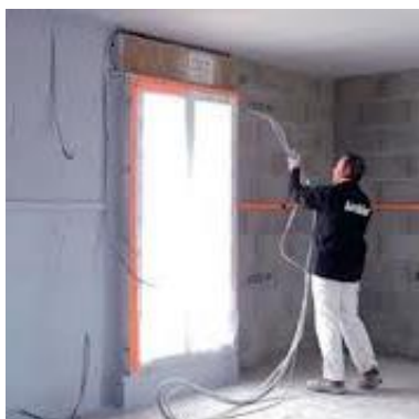
Enduit projeté d'étanchéité à l'air weber.mur int'air Source : Saint-Gobain
