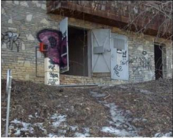
Entrée du local système de production solaire (ancienne chaufferie)
