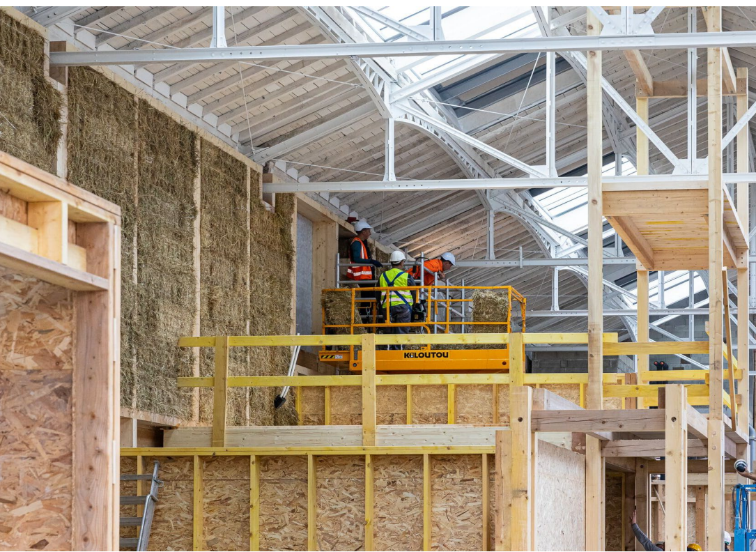
Murs ossature bois et isolation en paille de riz
