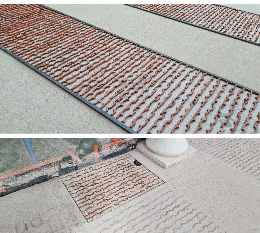
Sol en terrazzo avec motif à base de tuiles existantes recoupées
