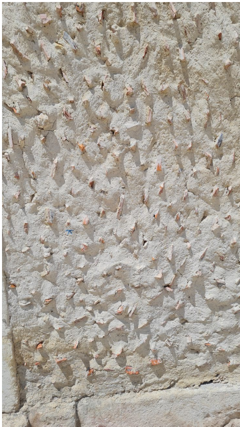
Intégration de tuiles cassées dans l'enduit extérieur
