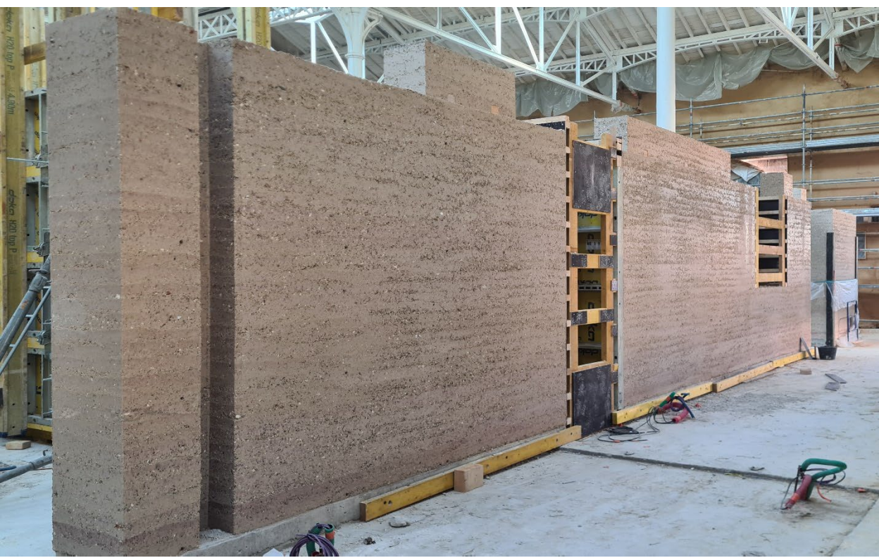
Mur porteur en pisé (béton recyclé & poussière de pierre de Fontvieille)
