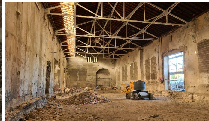
Dépose des tuiles, conservation charpente métallique
