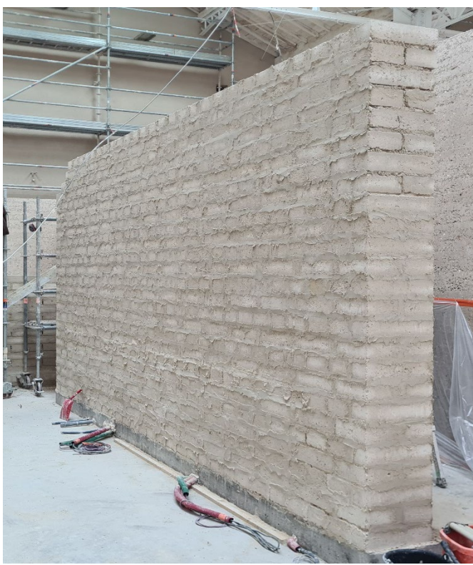
Mur porteur en briques de terres compressées
