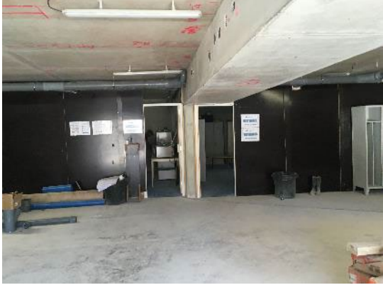
Stockage des matériaux sensibles à l'abri de la pluie (en containers puis en sous-sols).
