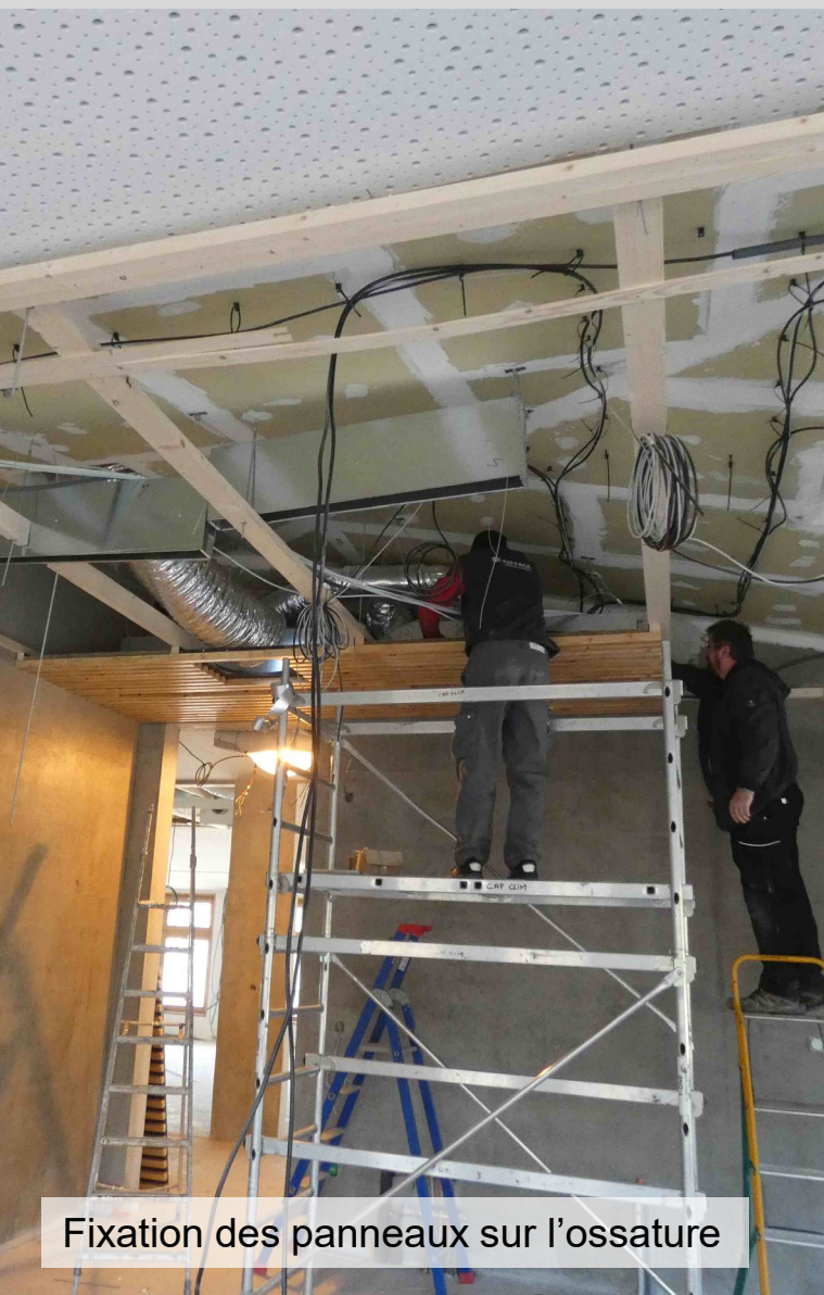
Gainage ventilation et attente électrique
