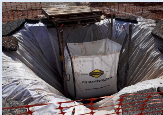
Zone de décantation des eaux béton
