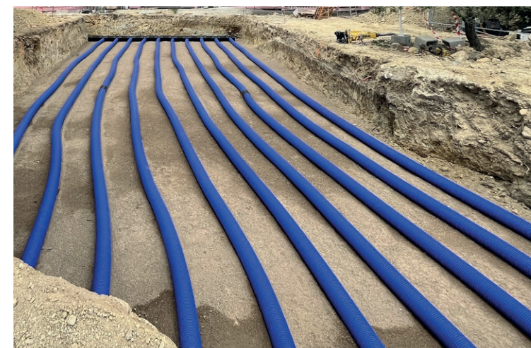
10 tubes enterrés en PEHD - ©NeM Architectes
