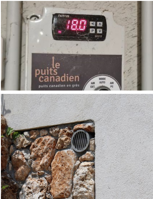
1. Boîtier de suivi du puits - 2. Prise d'air du by-pass ©EnvirobotBDM
