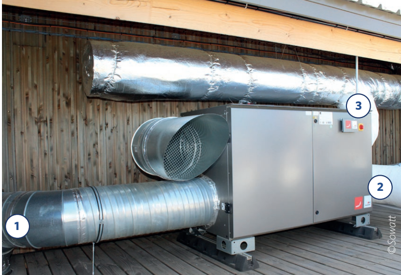
1-Arrivée réseau issu du puits 2-Soufflage 3-Reprise
