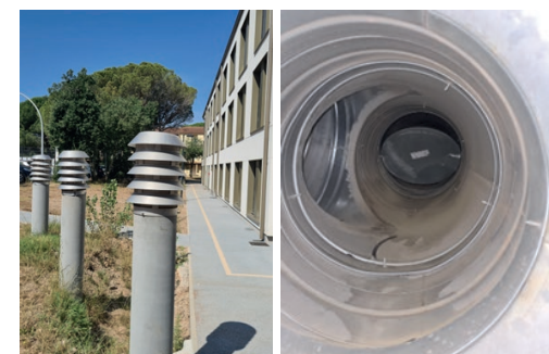
3 prises d'air tube acier By-pass ouvert ©Sowatt
