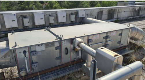
Caisse de VMC simple flux en toiture avec batterie thermique ©Sowatt
