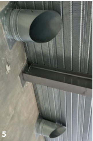
1.Prise d'air extérieure 2.Grilles de soufflage en pied de serre 3.Arrivée des conduites côté soufflage 4.Cheminement de l'air dans l'espace de la serre 5.Conduits de tirage VMC en partie haute de la serre - ©EnvirobatBDM
