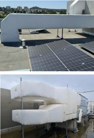
Cheminement et CTA en toiture ©Sowatt
