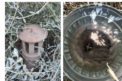
Prise d'air ombragée et filtrée ©EnvirobotBDM
