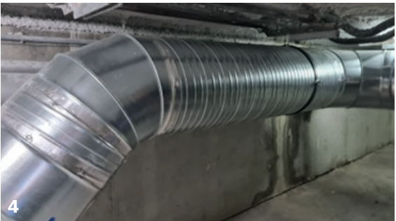
1- Prises d'air et conduits pendant le chantier ©Bureau Architecture Méditerranée. 2- Prise d'air. 3- Filtre G de la prise d'air. 4- Raccordement (diam 0,5) en vide sanitaire, non isolé. 5- a. Arrivée puits b. Soufflage c. Reprise d. Arrivée d'air ext via by-pass e. Rejet ©EnvirobotBDM
