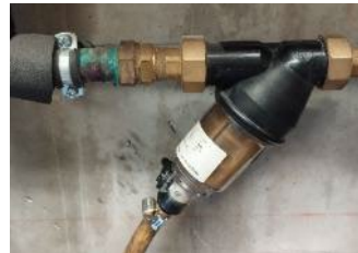
Figure 23 Photographies d'un filtre à tamis avec vanne de purge (à gauche) et d'un filtre à tamis classique (à droite)
