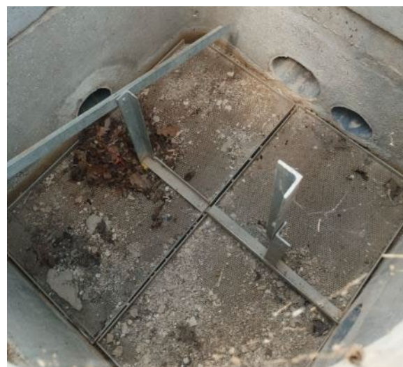
Figure 70 Grille permettant une première filtration grossière du flux entrant dans la cuve
