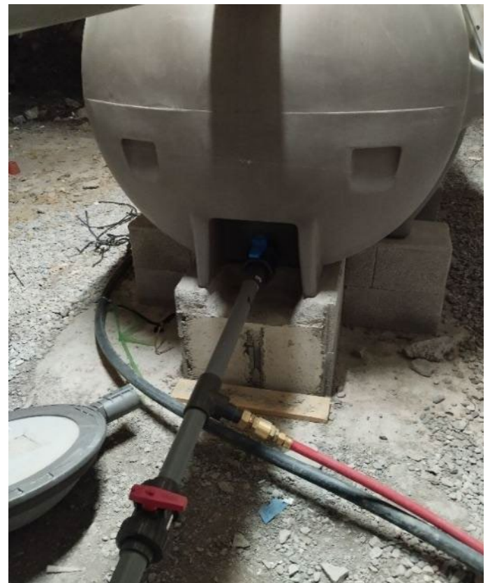
Figure 45 : Photographie du tuyau de relevage de la cuve de récupération en partie basse de celle-ci, en rouge à droite
