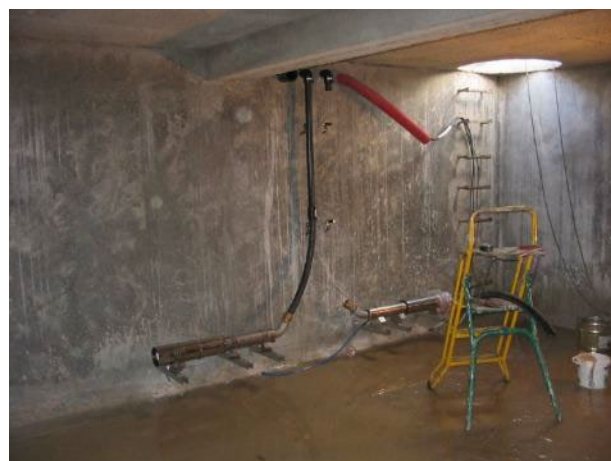
Figure 78 : Photographie de l'intérieur du bassin sud, des pompes immergées en cours de pose ainsi que du regard d'accès. Image appartenant à la MOA.
