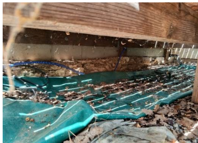
Figure 90 : dépôt végétal formé sur une cuve souple
