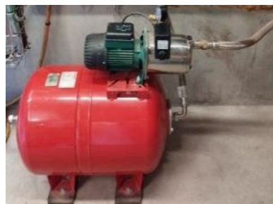
Figure 47 Photographie du dispositif de pompage et surpression composé de la pompe centrifugeuse et du réservoir à diaphragme
