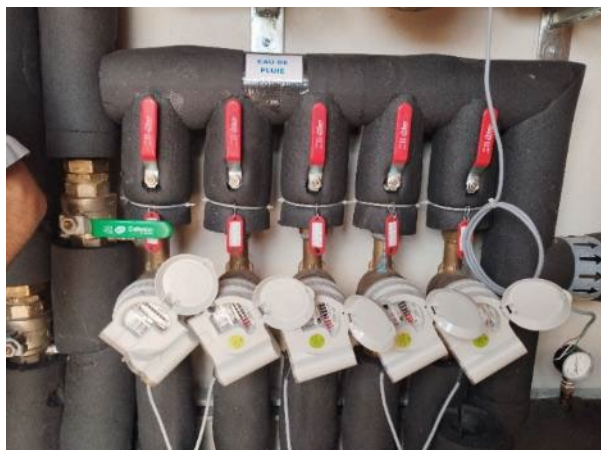
Figure 73 : Photographie des compteurs d'alimentation en eau de pluie des quatre logements collectifs et de la
