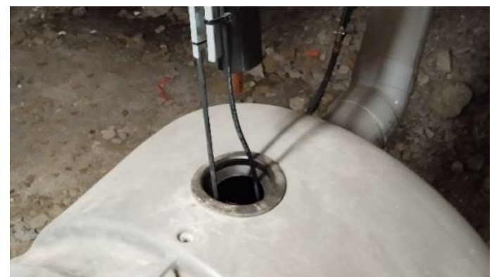
Figure 46 : Photographie de l'orifice ouvert sur la partie supérieure de la cuve de stockage des eaux de pluie
