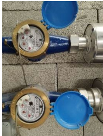
Figure 59 Photographie des compteurs de l'eau de pluie
