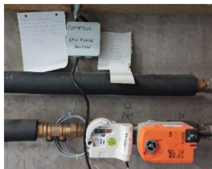
Figure 48 Compteur d'appoint en eau potable et relevés manuels conservés sur papier à côté
