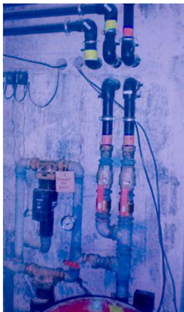
Figure 76 Photo des rubans distinctifs et d'une étiquette manuscrite pour l'identification des réseaux au sein du local technique 1bis. Photo imprimée en noir et blanc sur le cahier de suivi des travaux.
