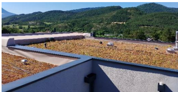
Figure 40 : Photographie d'une partie des toitures végétalisées avec présence des canaux d'irrigation
