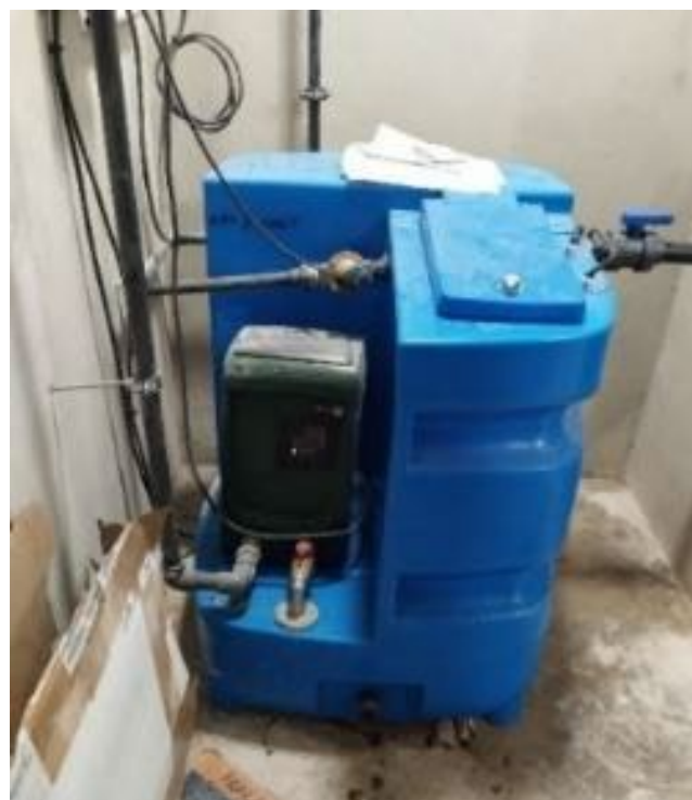
Figure 34 : système gestionnaire des eaux de pluie dans le local technique R-1 du bâtiment A
