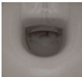
Figure 71 : dépôts visibles dans l'eau du sanitaire
