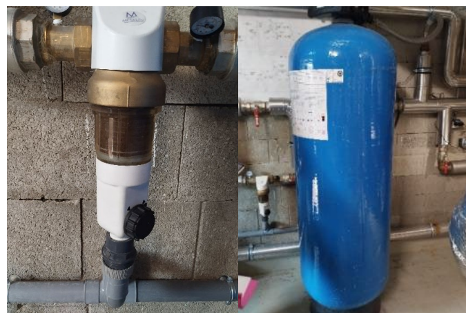
Figure 58 - Filtre à maille (à gauche) et filtre à sable (à droite)
