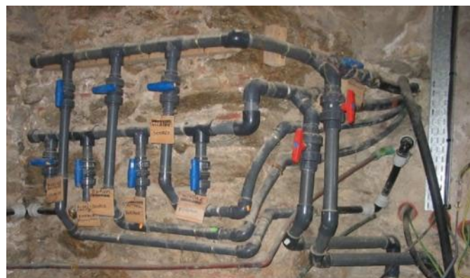
Figure 77 : Photo de 3 usages alimentés à la fois par l'eau du forage (potable) et par l'eau du bassin. Le choix de l'alimentation se fait par action des vannes. Image appartenant à la MOA.
