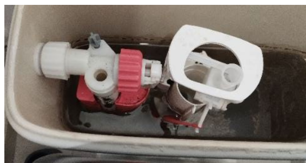
Figure 37 : eau de pluie stockée dans le réservoir des sanitaires, illustrant un déficit de filtration
