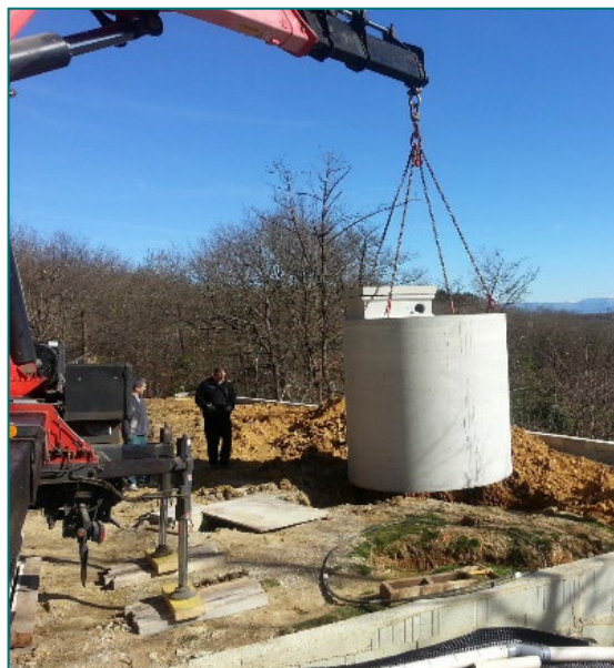
Figure 16 Installation d'une citerne en béton de 10 m³ de récupération d'eaux de pluie (Source : Stockao)
