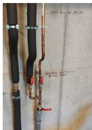
Figure 42 : Photographie du réseau d'alimentation des sanitaires et de l'arrosage et de sa vidange, en bas à droite
