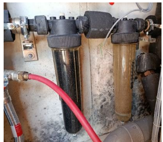
Figure 22 Installation couplant un filtre à cartouche de 90 µm de maille de filtration (à droite) et un filtre à charbon actif (à gauche) avec défaut d'entretien
