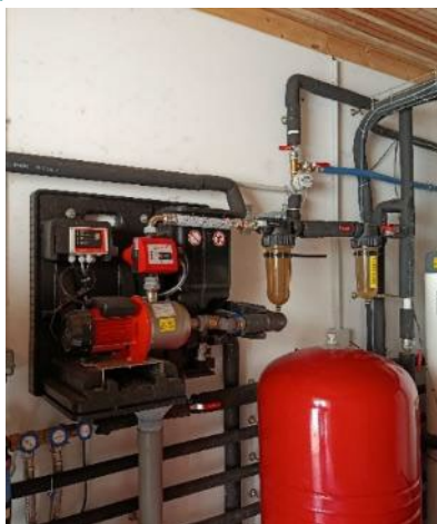
Figure 52 Système manufacturé gestionnaire et vase d'expansion
