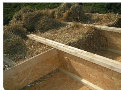
**paille** (Botte sur chant  $\lambda$ = 0,052 W/m.K) et densité entre 80 et 120 kg/m<sup>3</sup> déphasage et 6.92 **en 360 mm**
