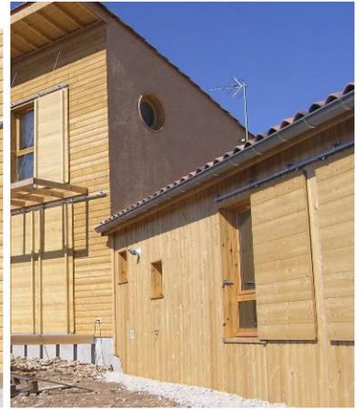
finition bardage mélèze vertical avec couvre joint ...ou vibrato
