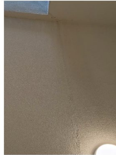
Fuite au niveau des ouvertures de désenfumage (coulures en intérieur)
