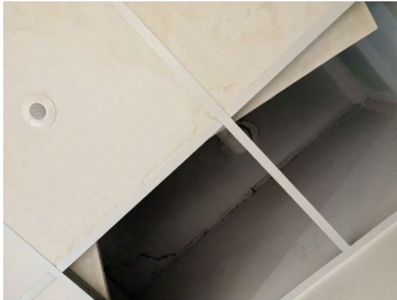
Infiltrations dans les WC du dernier étage :
