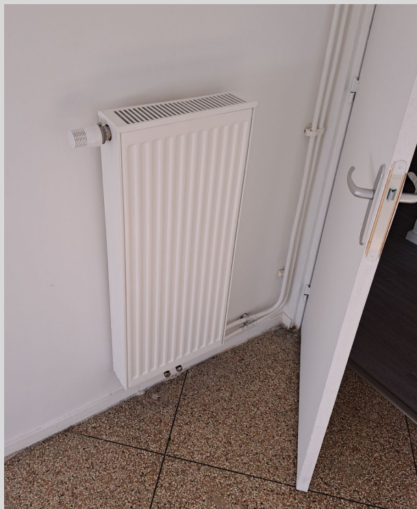
Plancher chauffant remplacé par des radiateurs avec robinet th.
