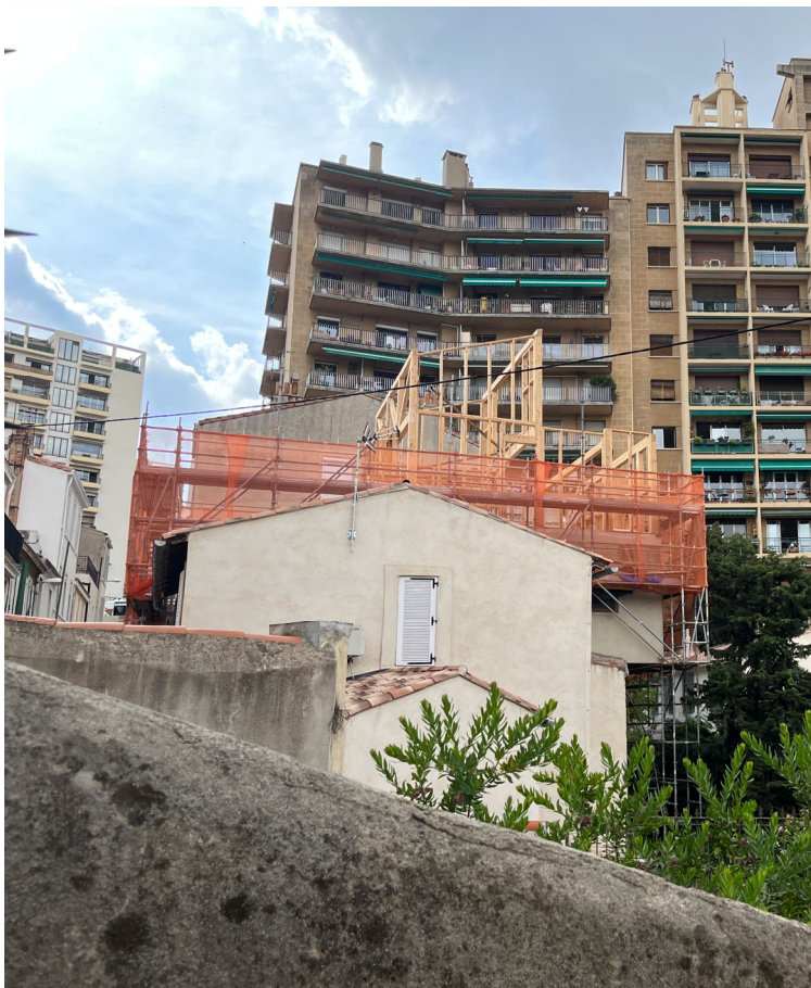
Levage et mise en œuvre de la structure bois @ Dimension Bois
