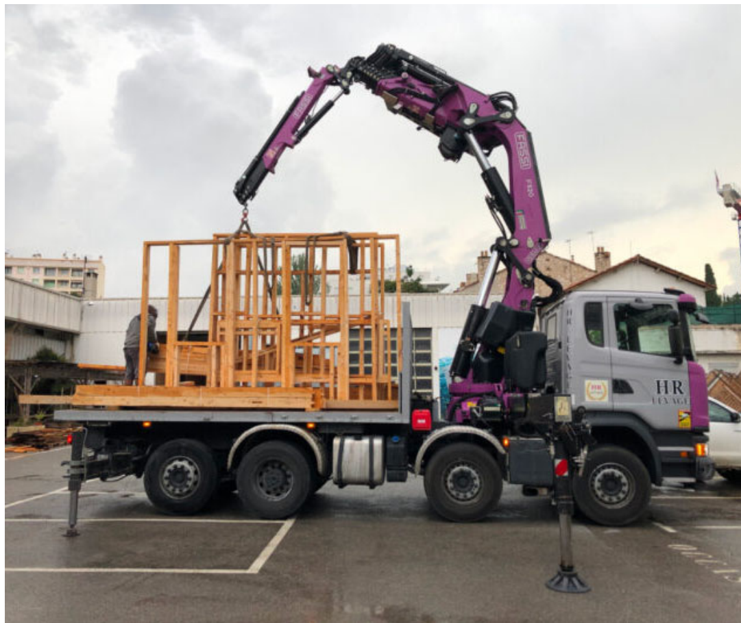
Acheminement et levage de la structure bois @ Dimension Bois
