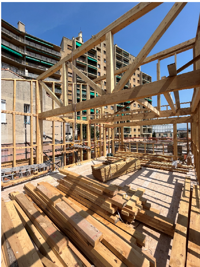
Mise en œuvre de la structure bois @ Dimension Bois
