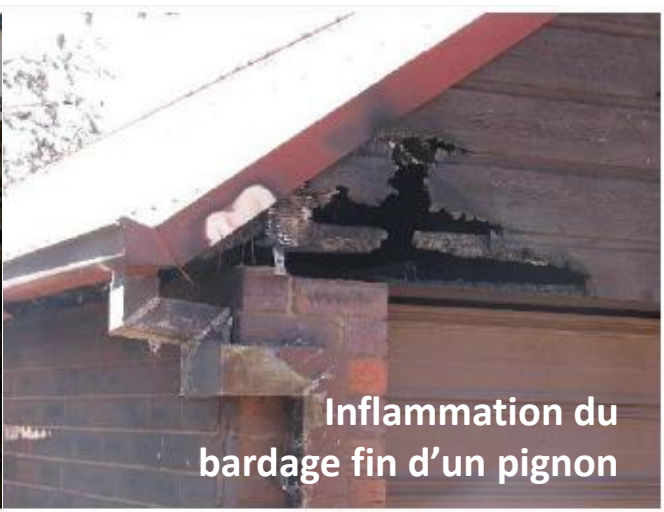
Départ de feu dans un interstice entre le bandeau et une bavette métallique
