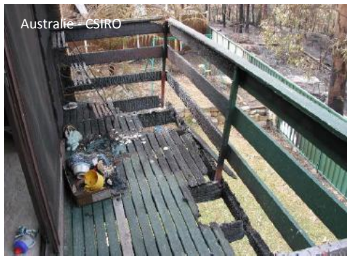
Deux exemples de platelages bois enflammés par des brandons et éteints par l'occupant.
