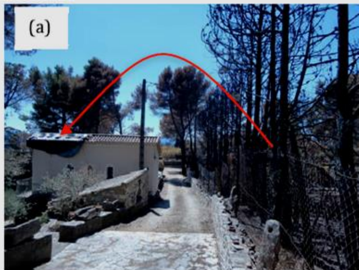
Fig. 69 : Dommages observés sur l'habitation CAV_16 : (a) toiture endommagée par les particules incandescentes de la haie de cyprès en combustion (b) volet en bois (façade nord-ouest) légèrement noirci
