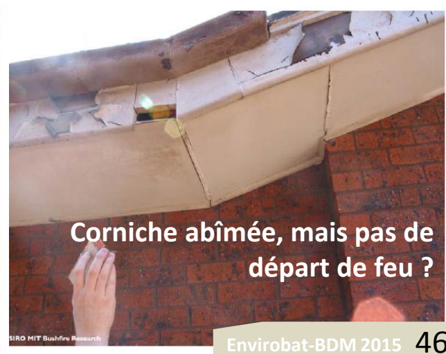
Inflammation du bardage fin d'un pignon
