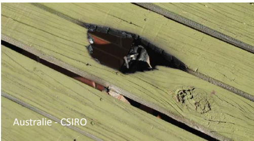
Deux exemples de platelages bois enflammés par des brandons et éteints par l'occupant.
