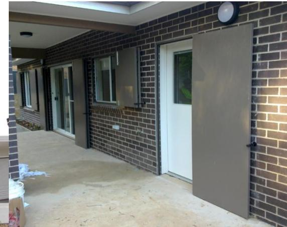
Des volets en bois résistant au feu de forêt sont fabriqués pour le niveau BAL 29 (c'est-à-dire pour un flux thermique maximum de 29 kW / m<sup>2</sup>).
