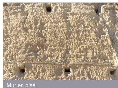
Mur en pisé
