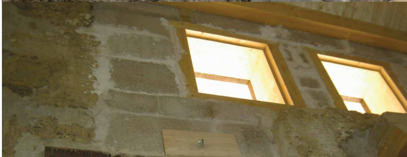
Mise en place de blocs de « chanvribloc » permettant facilité de pose et gain de temps.
