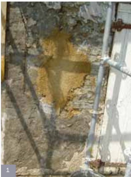
1 : Enduit renformi appliqué sur les aspérités de la surface 2 : Préparation du renformi 3 : Façade Nord fortement abimée par l'enduit ciment et entièrement recouverte d'enduit renformi
