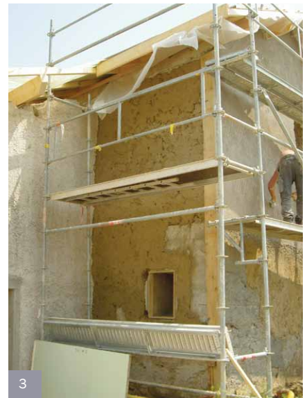
1 : Enduit renformi appliqué sur les aspérités de la surface 2 : Préparation du renformi 3 : Façade Nord fortement abimée par l'enduit ciment et entièrement recouverte d'enduit renformi
